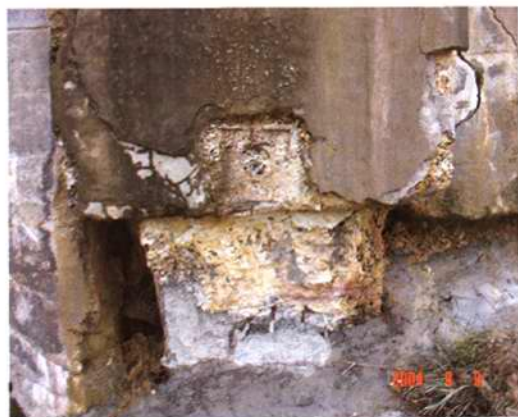
图 6 预应力锚索粘结失效实例
