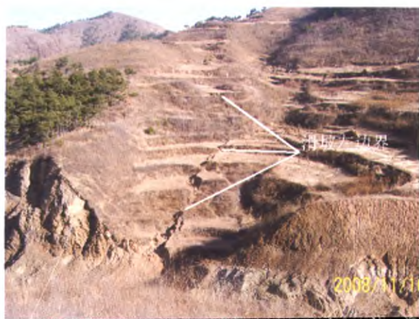
图3 滑坡左边界裂缝已贯通
