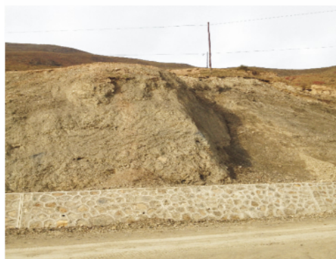
图4 库岸塌岸及人工开挖边坡
