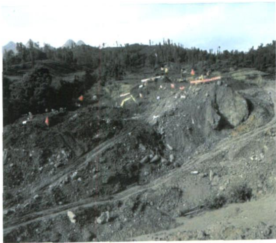
图 4 滑坡前缘碎石土夹块石堆积
