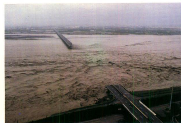
照片6 高雄县双圆大桥被洪水冲毁(照片来源:台湾经纬卫星信息公司)
