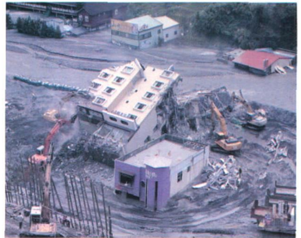
照片 10 建筑物挤占河川低位阶地, 是造成洪 水灾害损失的重要原因(陈树群摄)
