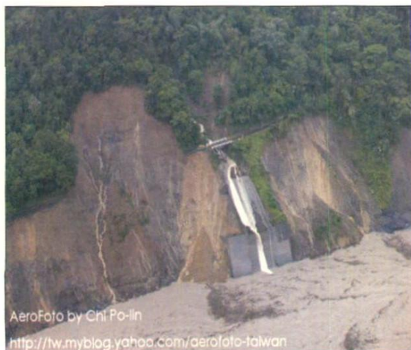
照片1 群发性滑坡崩塌沿道路发育。这是通往高雄县六龟乡的台27公路路基被沿线的滑坡群毁坏的情形。(齐柏林摄)
