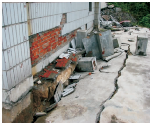
照片8 狮子梁端部凸出地形顶部塔基震陷破坏
