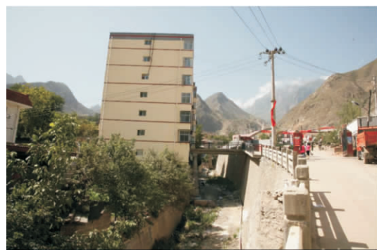
图10 舟曲县泥石流排导沟断面过小现象
