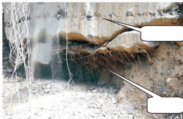
(b) 8月19日 坝基钢管桩出露
