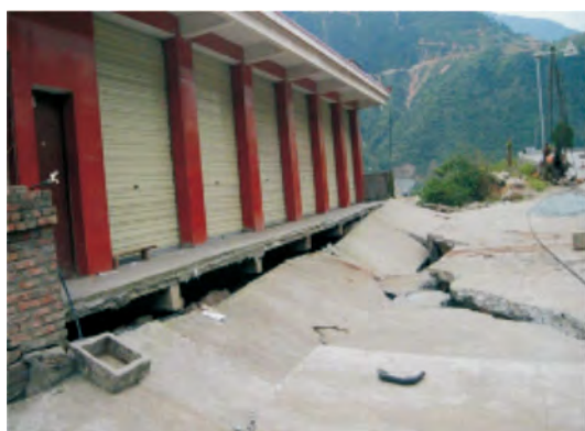
图 1 国道 G108 线外侧出现的地面沉陷和房屋倾倒现象
