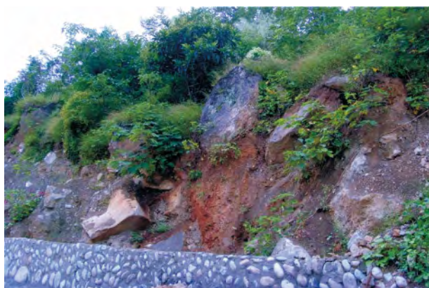
图5 滑坡堆积体A区前缘水渠内侧出露的巨型块石堆积
