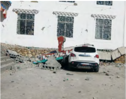
a. 塔公镇木雅祖庆学校框架结构墙体垮塌(Ⅶ度区)
