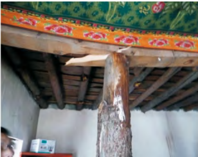
b. 塔公镇夏马龙村民房横梁断裂(Ⅶ度区)
