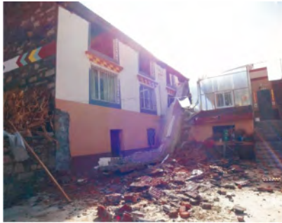
c. 八美镇石木结构民房墙体垮塌(Ⅶ度区)
