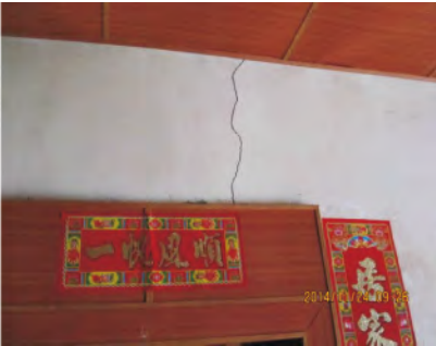
f. 磨西镇榆林村石木结构民房墙体开裂(Ⅵ度区)
