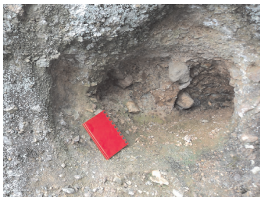
图5 砾石脱落形成凹陷
