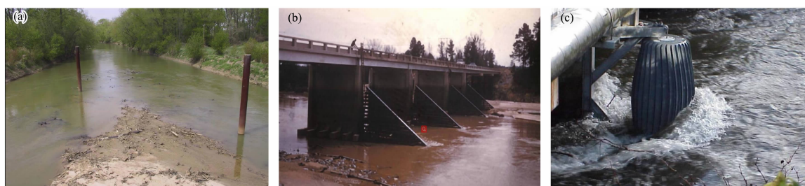
图3 桥墩保护装置:(a) 导流桩 [29] ; (b) 导流鳍 [47] ; (c) 漂木清扫装置 [47]
