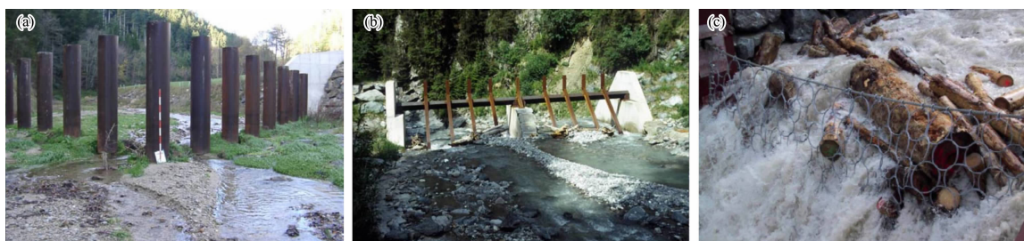
图5 阿尔卑斯地区的漂木防治措施:(a) V型桩林 [46] ; (b) 倾斜耙齿拦沙坝 [48] ; (c) 柔性格网坝 [49]
