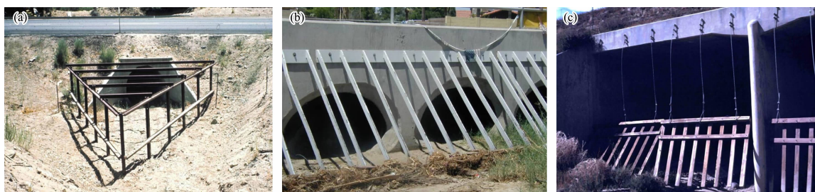
图4 涵洞保护装置:(a) 导流装置 [47] ; (b) 固定式拦截栅栏 [47] ; (c) 活动式拦截栅栏 [47]
