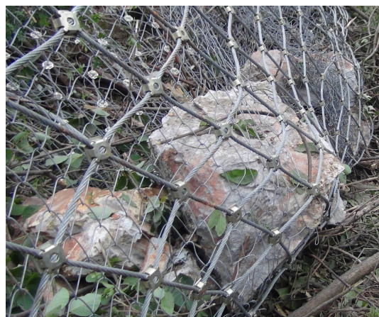
图4 堆积于防护网底部的落石
