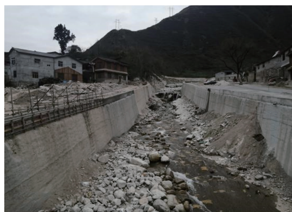
图 10 槽底损坏、侧墙磨蚀
