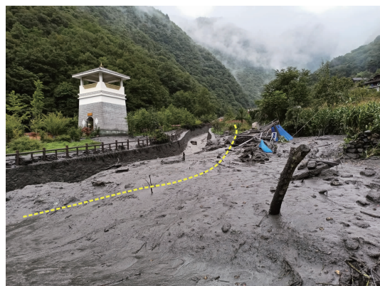
图 9 沟口排导槽弯道超高
