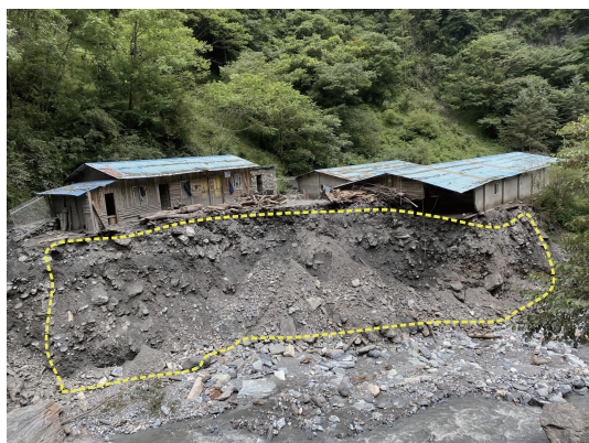
图 7 沟道被冲刷侵蚀
