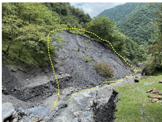
图 6 中上游沟道岸坡失稳
