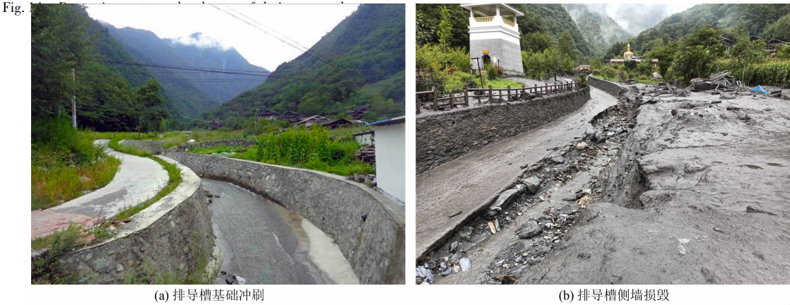
(a) 排导槽基础冲刷 (b) 排导槽侧墙损毁
