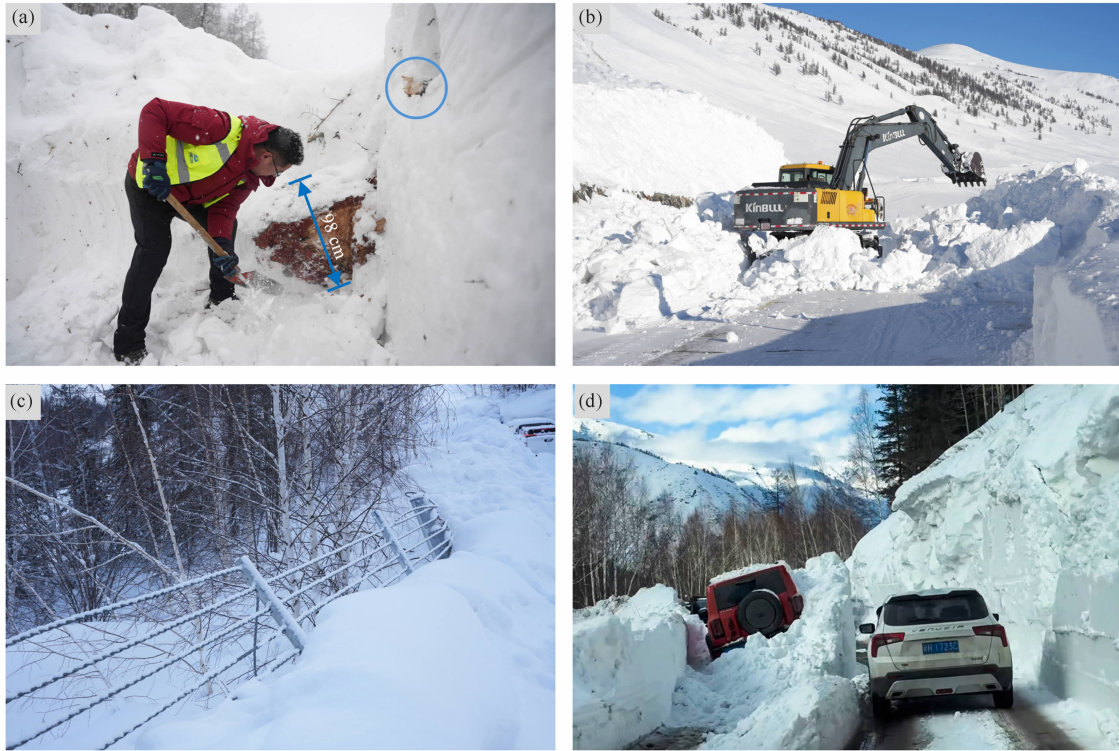
图4 雪崩灾害影响典型案例:(a)雪崩裹挟树木;(b)雪崩堵塞公路;(c)损坏公路构筑物;(d)雪崩掩埋车辆
